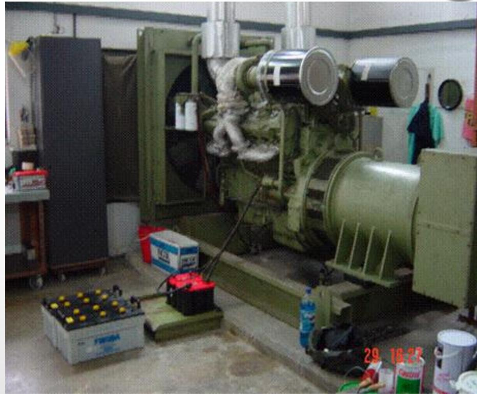
**En ambos casos se pudo remplazar 2 baterías convencionales 8D por 2 baterías OPTIMA 34/78**
